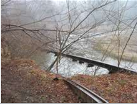
Ex-sedime eroso dal fiume Olona con la rotaia rimasta sospesa nei pressi di Malnate (R. Rovelli, 2009)
