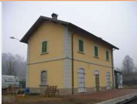
Stazione di Malnate, in ottimo stato di conservazione (R. Rovelli, 2009)
