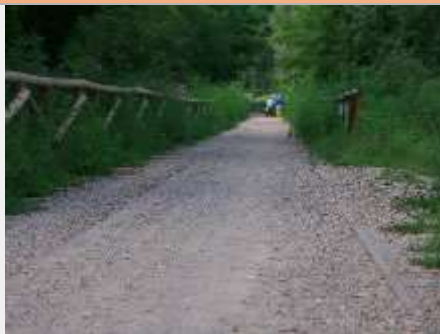
Percorso ciclo-pedonale realizzato sull'ex-sedime tra Gornate Olona e Castiglione Olona, da cui riaffiorano ancora le rotaie (S. Benedetti, 2010)
