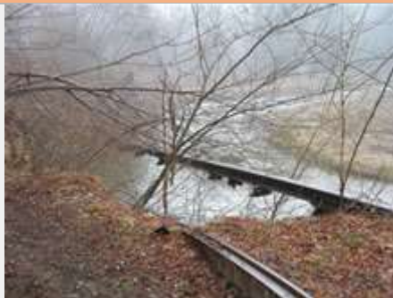
Ex-sedime eroso dal fiume Olona con la rotaia rimasta sospesa nei pressi di Malnate (R. Rovelli, 2009)
