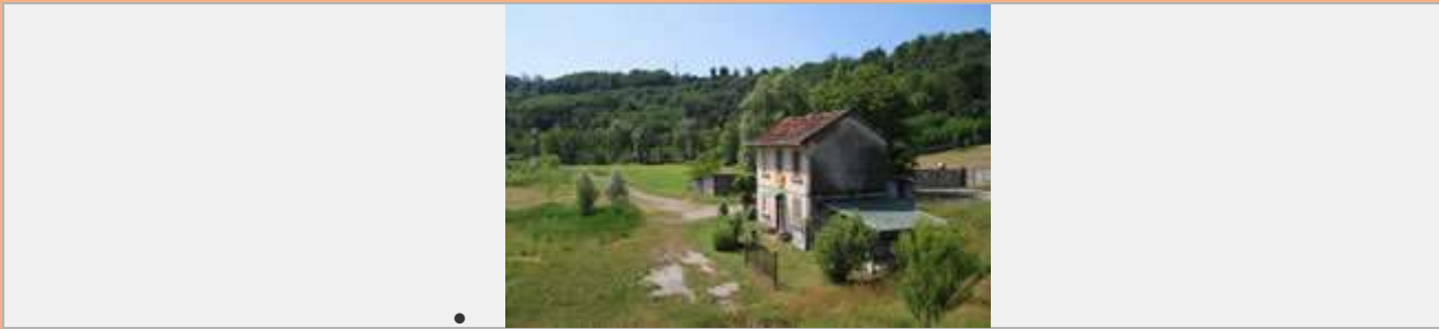
Ex-fermata di Bizzozzero-Gurone, in discreto stato di manutenzione (M. Viganò, 2015)
