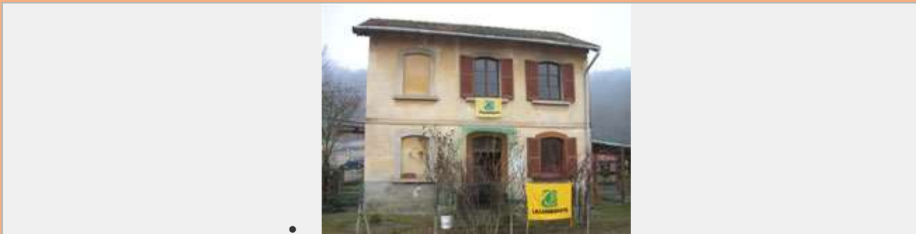
Ex-casello di Gurone, in discreto stato di conservazione (R. Rovelli, 2009)
