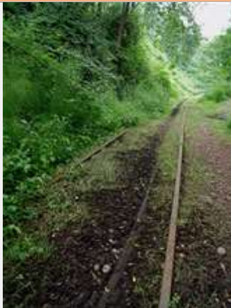
Binario ancora armato in località Crotto (A. Marcarini, 2008)
