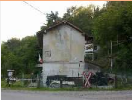
Un'altra immagine dell'ex-casello in discreto stato di conservazione, con i resti della croce di S. Andrea che indicava l'attraversamento ferroviario (R. Russo, 2011)
