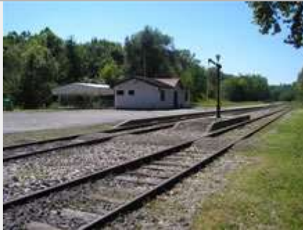
Ex-stazione di Rodero-Valmorea, oggi utilizzata per un servizio ferroviario turistico (F. Rapiti, 2009)
