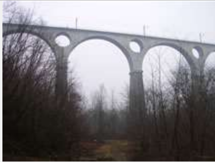
Ex-sedime sotto il viadotto di Malnate della linea Milano-Varese delle FNM (R. Rovelli, 2009)
