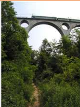
Ex-sedime sotto il viadotto di Malnate della linea Milano-Varese delle Ferrovie Nord Milano (A. Marcarini, 2008)
