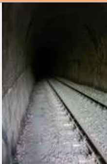
Interno della galleria Campagnola, tra Comignago e Arona (A. Negri, 2017)
