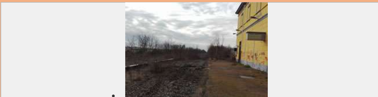
Ex-stazione di Buronzo, in stato di abbandono (F. Gianella, 2017)
