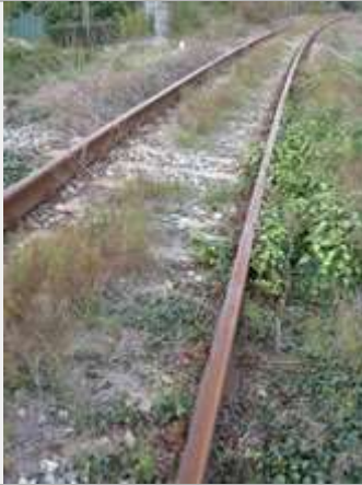
Sedime ferroviario con vegetazione spontanea in rapida crescita nei pressi di Gattinara, in direzione Arona (Alessandro, 2013)
