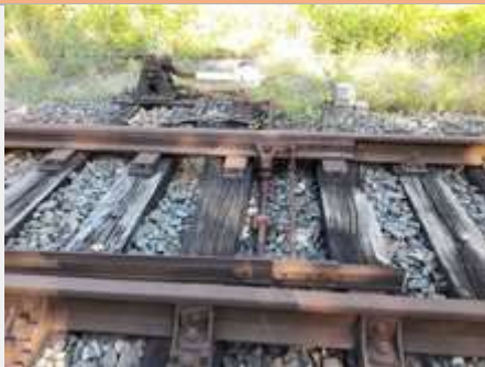
Particolare dello scambio per l'accesso allo scalo merci della stazione di Rovasenda Alta (Damiano, 2017)
