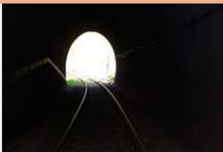
Uscita della galleria di Campagnola, lato Arona, con la sede ferroviaria in buone condizioni (C. Sora, 2014)
