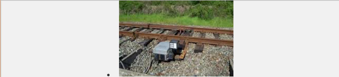
Particolare della cassa di manovra del deviatoio in ingresso alla stazione di Comignago Particolare del sensore rotaia del BCA della stazione di Comignago (C. Sora, 2014)
