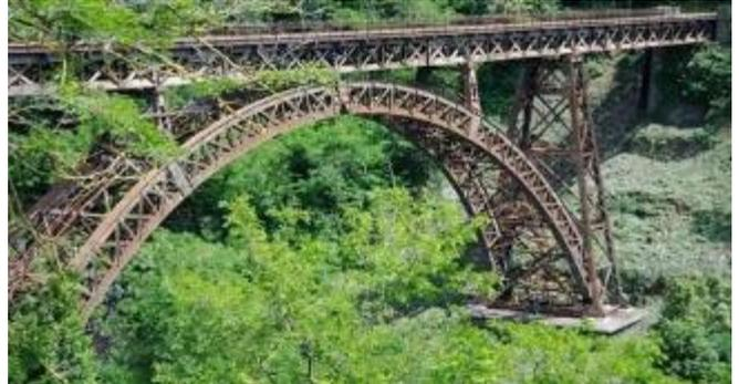
Il Ponte di Ronciglione è interamente chiodato con rivetti e non fa uso di saldature. Le macchine portatili per la saldatura, soprattutto quelle a elettrodi, si erano cominciate a diffondere solo dopo la Prima Guerra Mondiale (1918).
