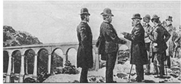
Autorità in visita durante i lavori della Porrettana, 1863. Sullo sfondo l'opera d'arte principale sul tratto toscano: il Viadotto di Fabbricaccia (o di Piteccio) sul torrente Castagno
