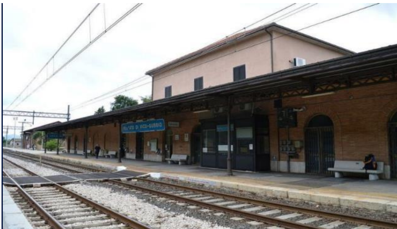
Stazione di Fossato di Vico-Gubbio
