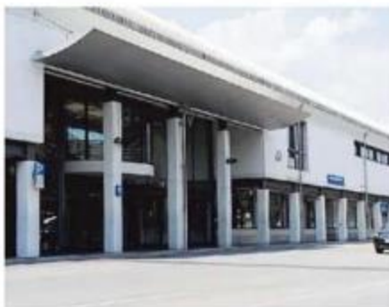
L'esterno della stazione ferroviaria a Gemona
