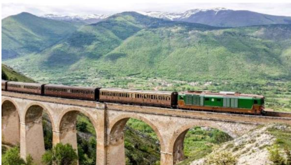
URBINO – Linea Ferroviaria
