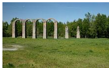
7 - Resti acquedotto romano
