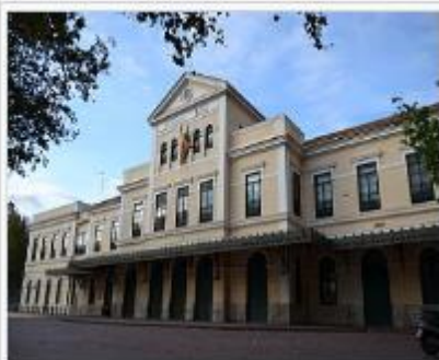
L'edificio della stazione, ora convertito in stazione di polizia
