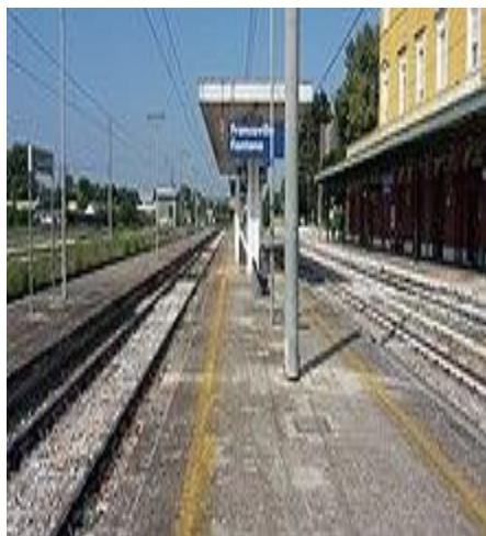
Piazzale binari Stazione Francavilla
