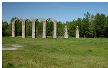
7 - Resti acquedotto romano
