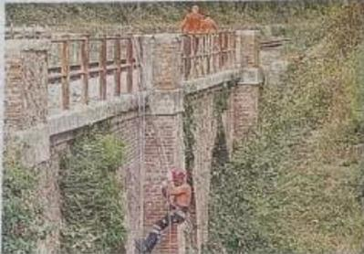
I tecnici di Fs in azione con corde e imbragatura per la verifica della tratta
