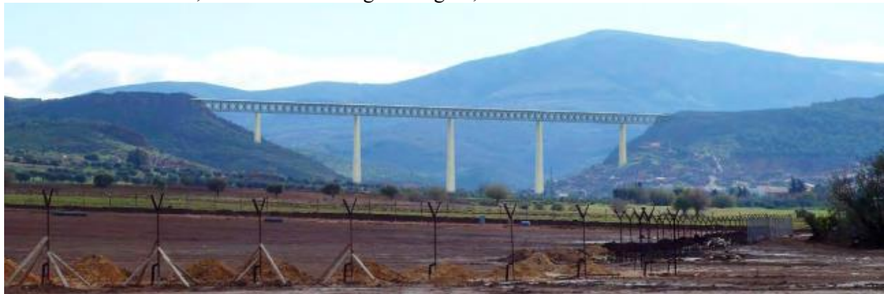
Viadotto M'Dig Tlemcen della ferrovia AV Oued Tlelat – Tlemcen
