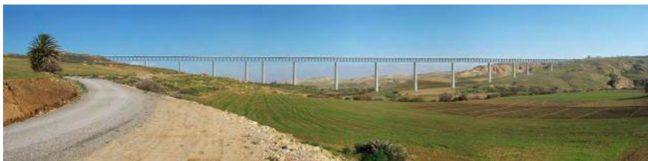
Viadotto Oued Isser della ferrovia AV Oued Tlelat – Tlemcen
