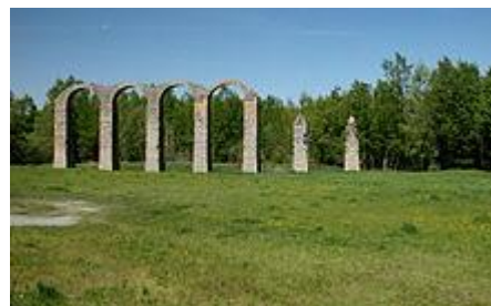
7 - Resti acquedotto romano
