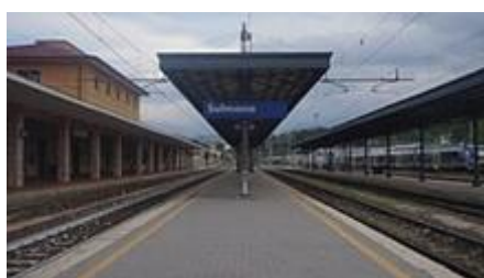
Veduta del piazzale ferroviario della stazione
