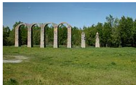
7 - Resti acquedotto romano
