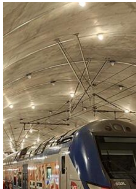
Particolare tralicci sospensione catenaria fissati sulla volta
