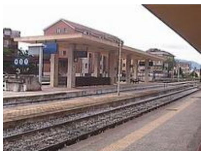
La stazione di Isernia lato binari
