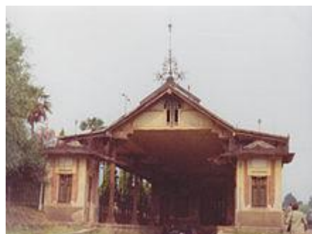
8 - Stazione ferroviaria degli anni Sessanta
